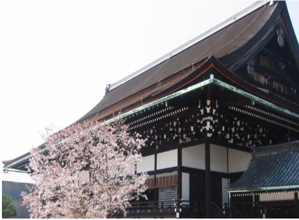
写真5. 京都御所の檜皮葺屋根
