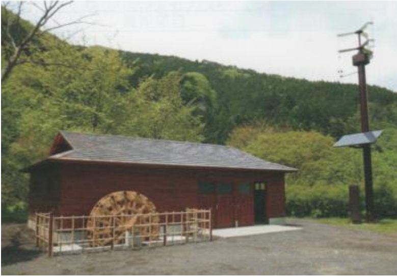
写真1. 山のふるさと村小水力発電建屋 12)
