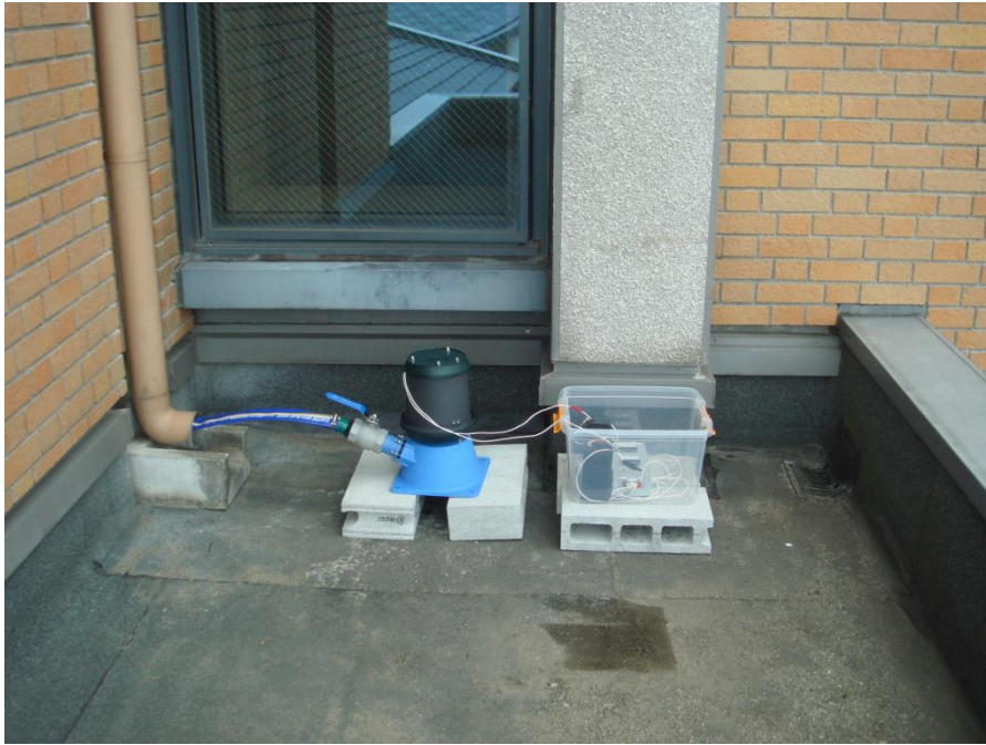
写真5. 関西外国語大学中宮学舎本館高層棟に設置したマイクロ水力発電器
